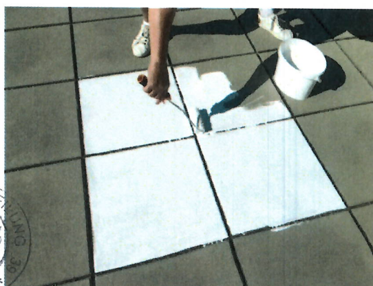
Bild 2 (IMG 1401): Aufrollen der Beschichtung Image 2 (IMG 1401): Roll up of coating
